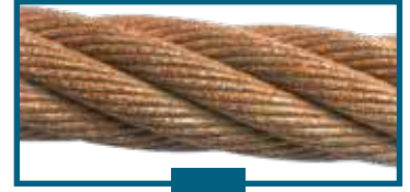
Dış korozyonun büyümüş hali Enlargement of external corrosion
